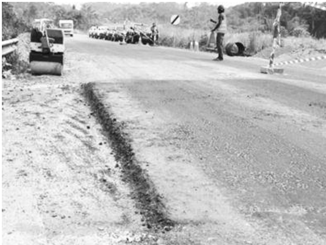
Le tronçon Bamenda-Batibo-Numba. Une vue du chantier.
