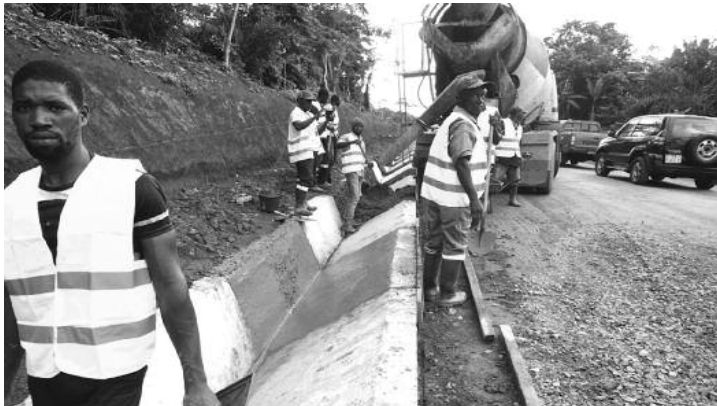
Pose des caniveaux sur l'axe Mbama-Messamena
