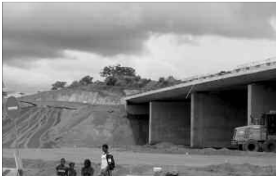
Une vue de l'échangeur du Carrefour Nsimalen, sur l'autoroute.
