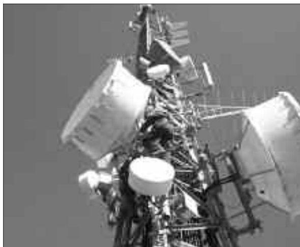
Un technicien sur le pylône.
