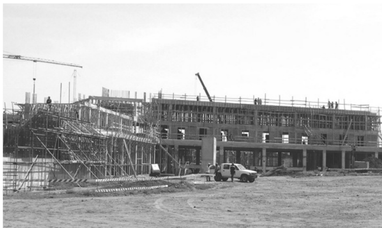
Une vue du chantier en question.
