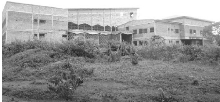
Le site de l'Egem en construction à Meiganga.
