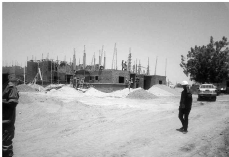
Un aperçu du chantier des logements sociaux de Bockle à Garoua.
