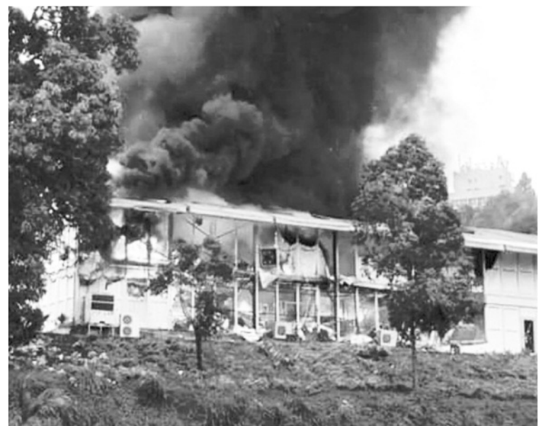
Oh secours le feu...
