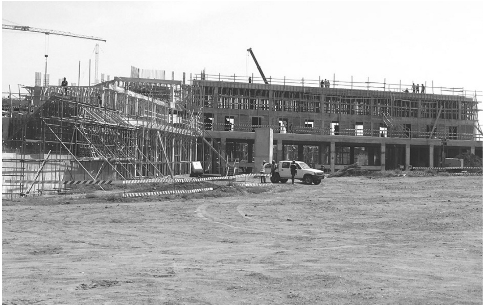
Infrastructures de la CAN à Garoua. A financer par l'emprunt obligataire.
