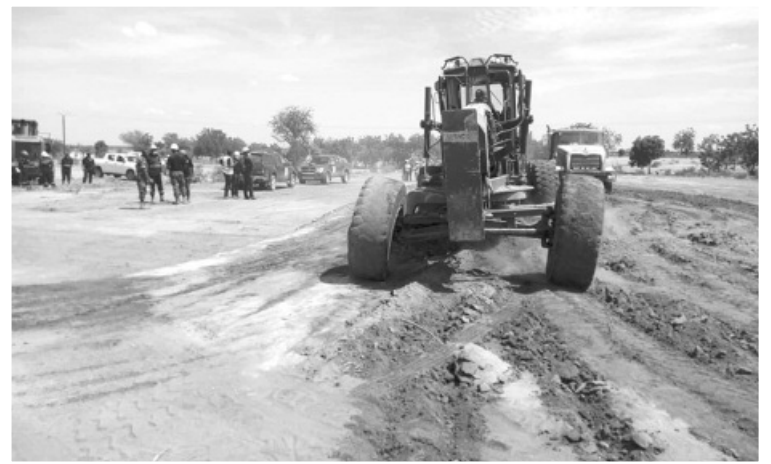
Démarrage des travaux du génie militaire.
