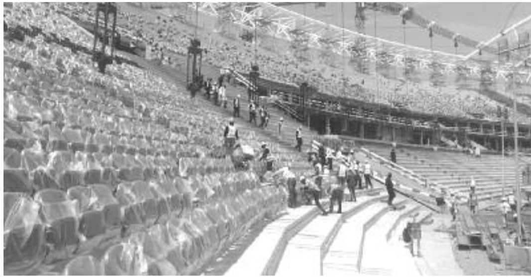
Yaoundé, le 11 novembre 2018. Une vue des gradins avec les sièges au stade d'Olembe
