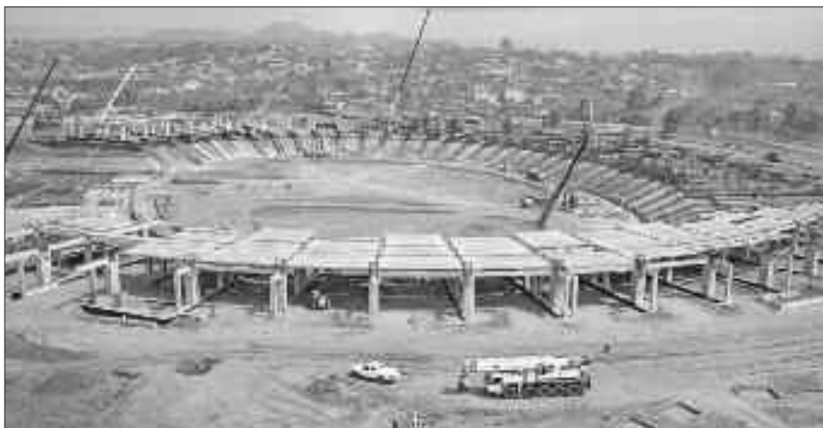
Chantier du stade Olembé.
