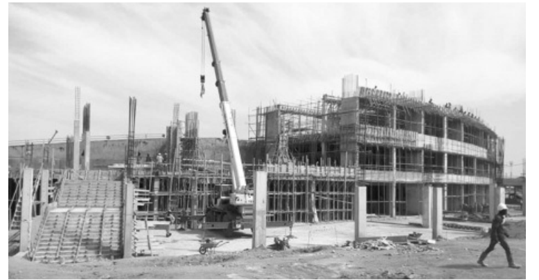
Un stade en construction à Garoua.
