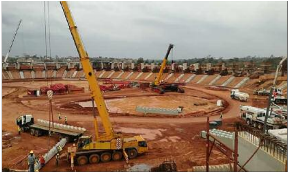
Chantier du stade Paul Biya d'Olembé.
