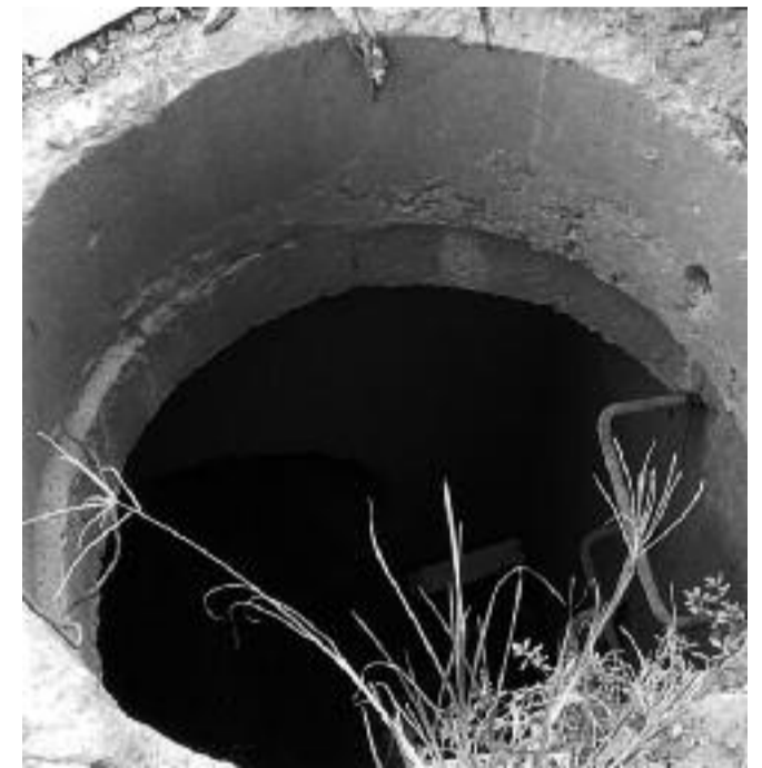
L'un des trois regards qui déversent les eaux qui ruissent sur la chaussée.
