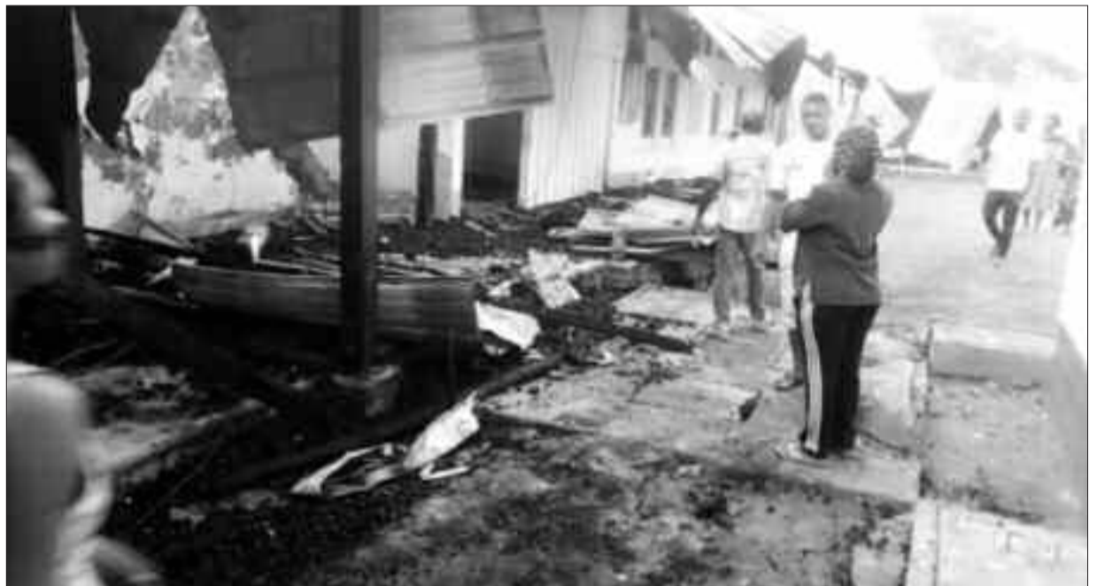
L'hôpital de district de Kumba incendié.
