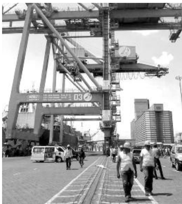
Une vue du 3ème portique de quai du Port de Douala.
